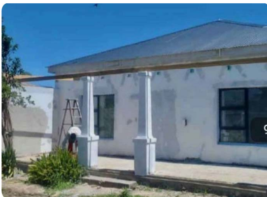
Figuur 3: Die deur is toegebou, vensters vervang en die veranda verwyder.
